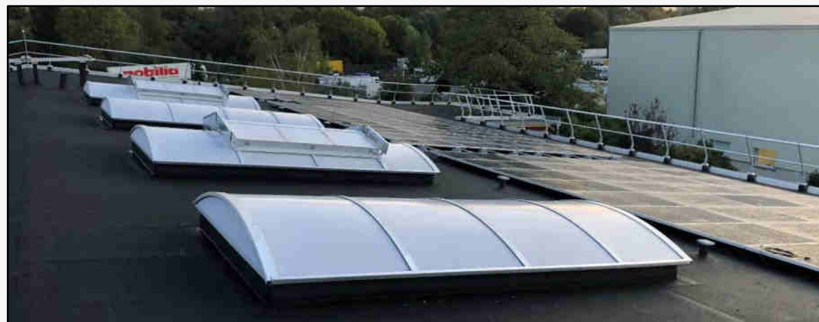
Av Marcelin Berthelot – Villeneuve-la-Garenne (92)
