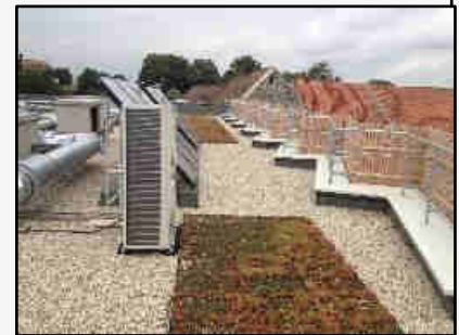
Foyer médicalisé Tremblay-en-France (93)
