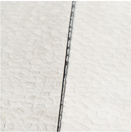
Dans le cas de membranes d'étanchéité avec sous couche grise ou noire les soudures sont bien visibles.
